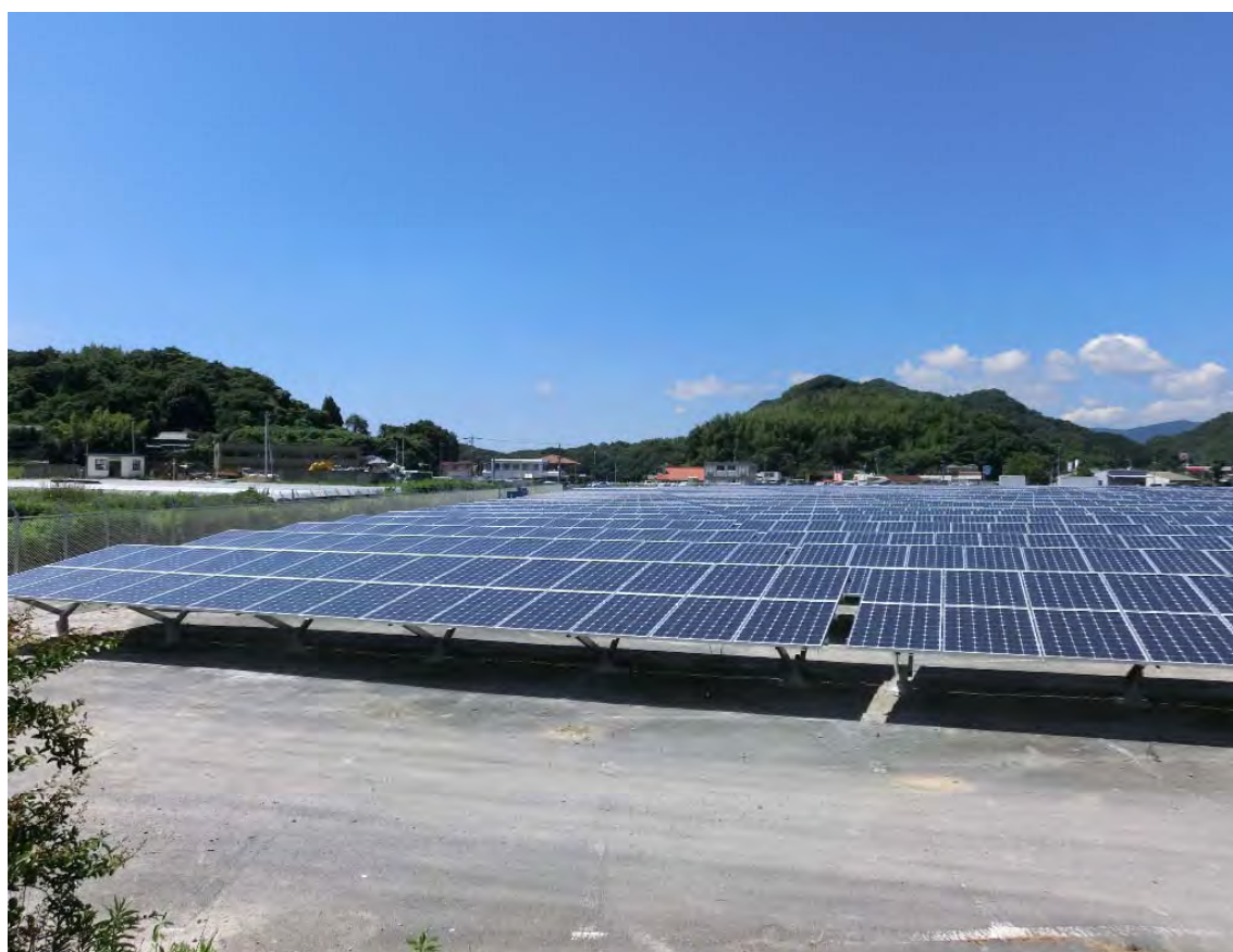
発電所南側より撮影
