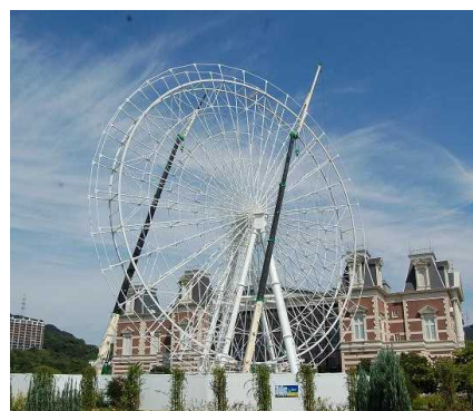
[9月26日の施工途中の様子]
